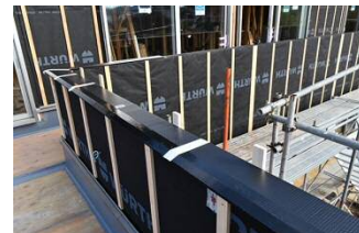
「笠木天端スパーサー」施工例※
