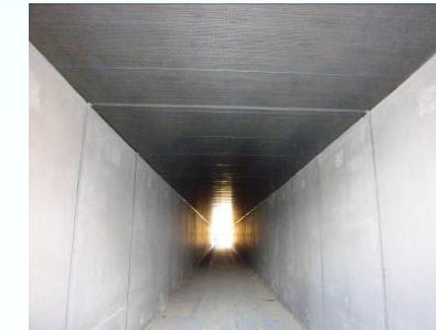
小島新田地区横断ボックス工事
