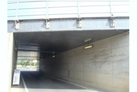
福島ジャンクション工事(既設 BOX 補修)
