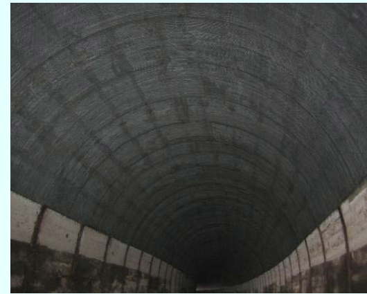
五能線汐見崎トンネル覆工修繕工事
