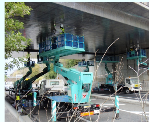
阪和地区保全工事(泉佐野IC橋補修工事)
