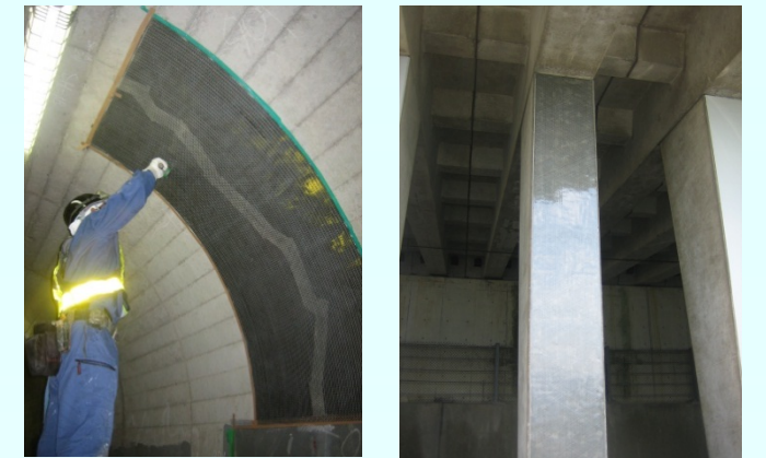
関東技術事務所・新素材繊維接着工 ロックシェッド・歩道トンネル試験施工
